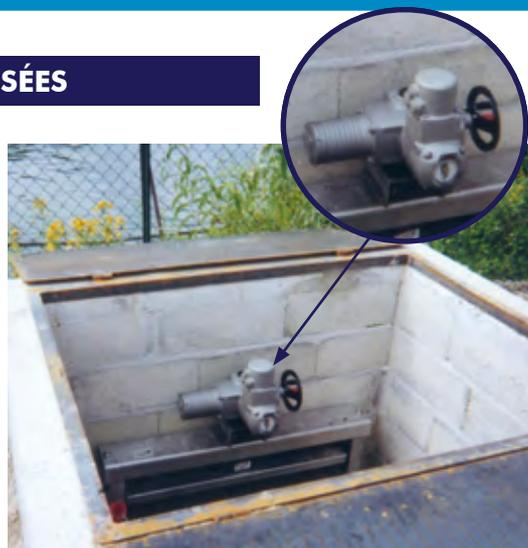
SERVOFLEX avec bloc de commande déporté : le bloc moteur est dans le regard, le bloc de commande est à l'extérieur du regard.
