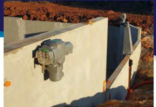
SERVOFLEX avec bloc moteur installé sur une colonne, commande déportée fixée contre une paroi.
